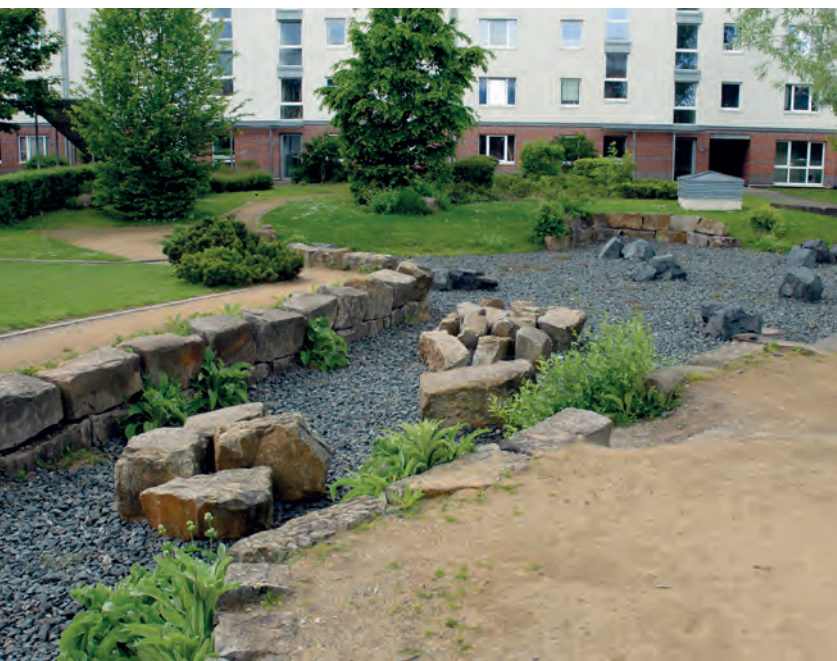
Abb. 11 Regenrückhaltefläche in einem Blockinnenhof
