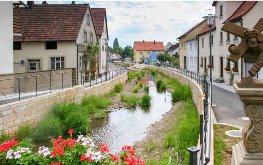
Abb. 36 Vergrößerung eines Bachprofils
