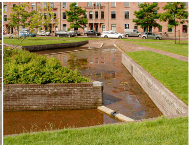
••• Abb. 63 Benthemplein - Platz nach einem Starkregen (oben) ••• Abb. 65 Bellamyplein - Zulauf vom Straßenraum (unten)
