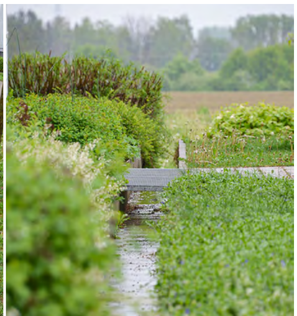
••• Abb. 45 Offene Ableitung von Niederschlagwasser
