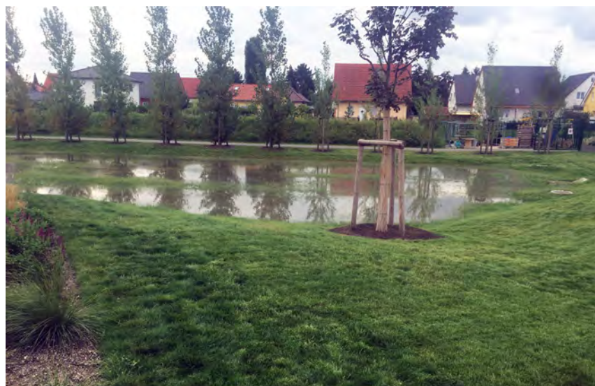
Abb. 43 Zentrale Regenrückhaltefläche in einem Wohngebiet
