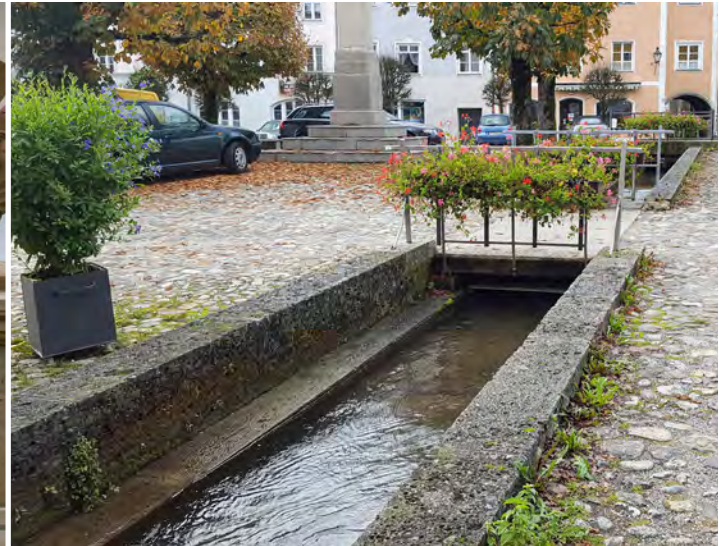
Abb. 37 Reaktivierung Dorfbach bei beengten Verhältnissen
